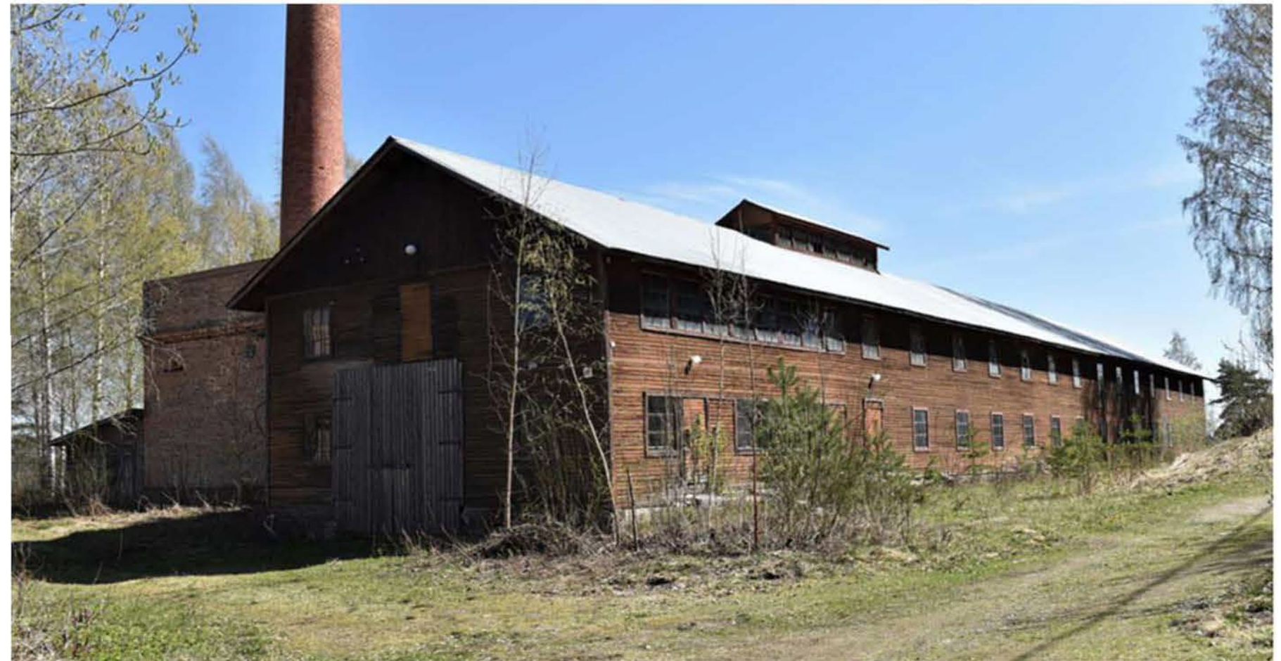
Maakunnallisesti arvokkaaksi maakunnallisessa rakennetun kulttuuriympäristön inventoinnissa määritelty Padasjoen Mainiemen saha. Kuva Teija Ahola, Hämeen ELY.
